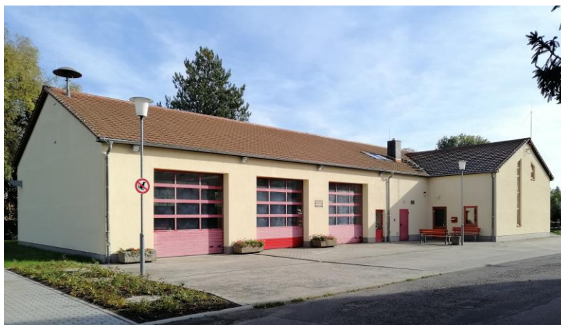
Feuerwehrhaus Panitzsch Standort: 04451 Borsdorf OT Panitzsch, Teichstraße 1a
